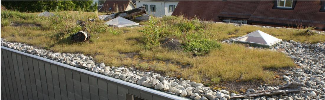
Legno morto di grosse dimensioni, cumuli di substrato, fasce di ciottoli, vegetazione densa e rada alternate: il tetto verde strutturato ricco di specie.
