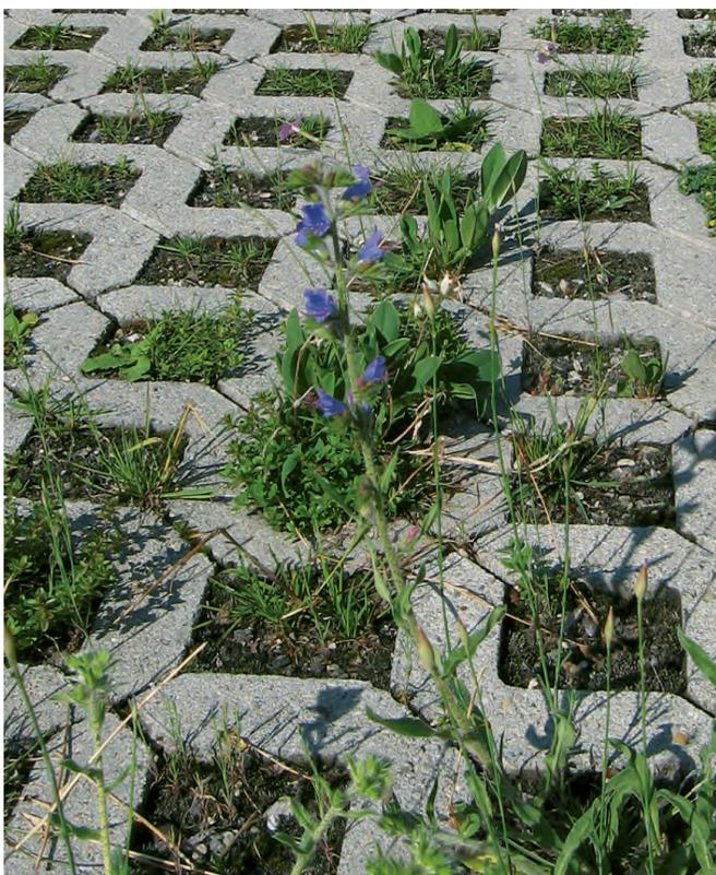
Les dalles alvéolées représentent une excellente alternative aux surfaces de stationnement en enrobé ou en béton. Elles confèrent au sol de la stabilité, sans le rendre imperméable.
