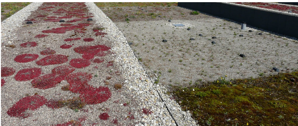
Unterschiedliche Substrat-Typen, Substrat-Höhen, funktionierende Drainagen, Beschattung und Begrünungsarten führen zu ganz unterschiedlichen Resultaten.
