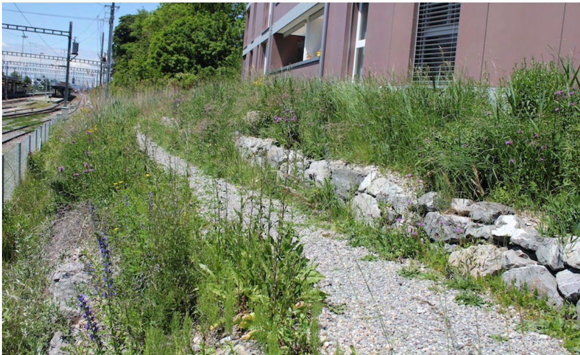
Trockensteinmauer entlang der Bahnlinie am Rande der Überbauung
