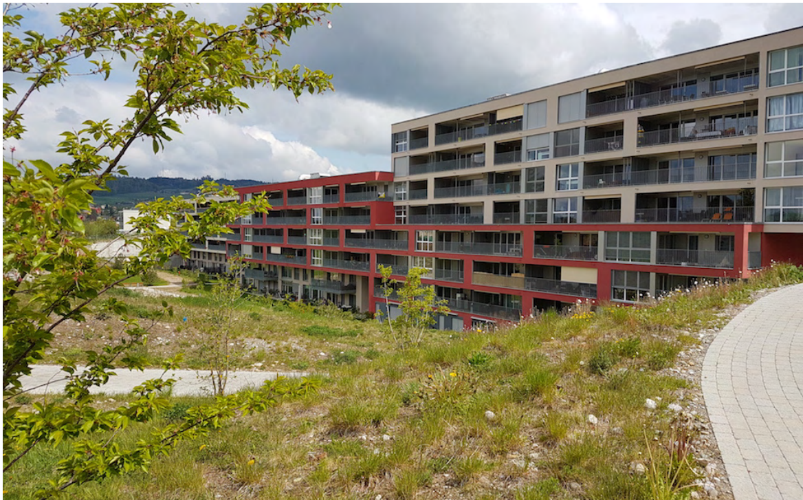
Zweite Bauetappe, die ein grosses Retentionsbecken inklusiv Laichzone für die Kreuzkröte beheimatet.
