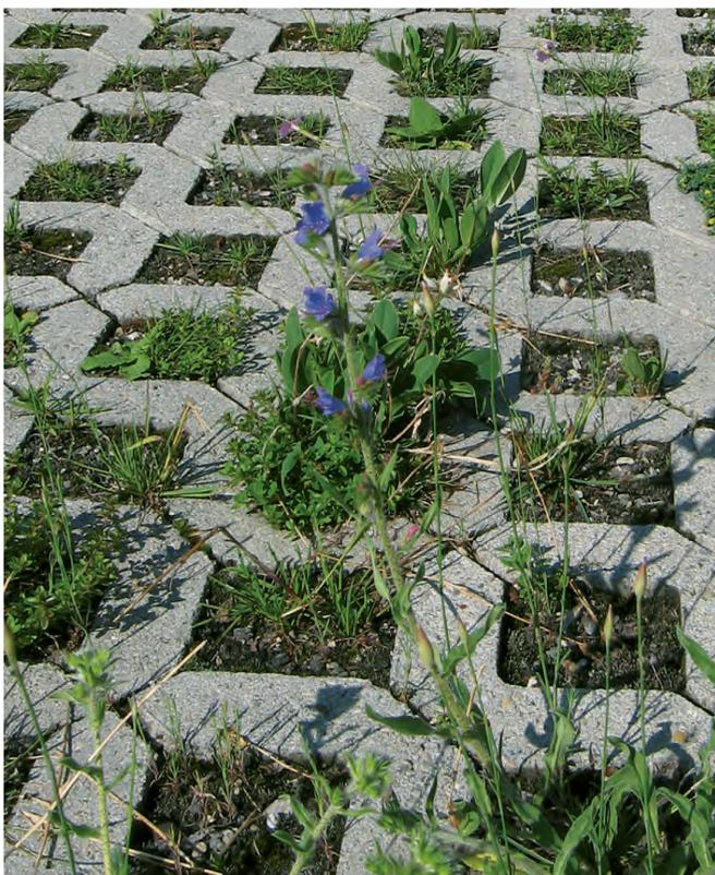
Rasengittersteine sind eine gute Alternative für Kies- oder Betonparkplätze. Sie geben dem Boden Stabilität ohne ihn zu versiegeln.
