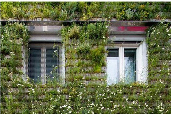
Abbildung 22 begrünte Fassade mit Kaskadensystem
