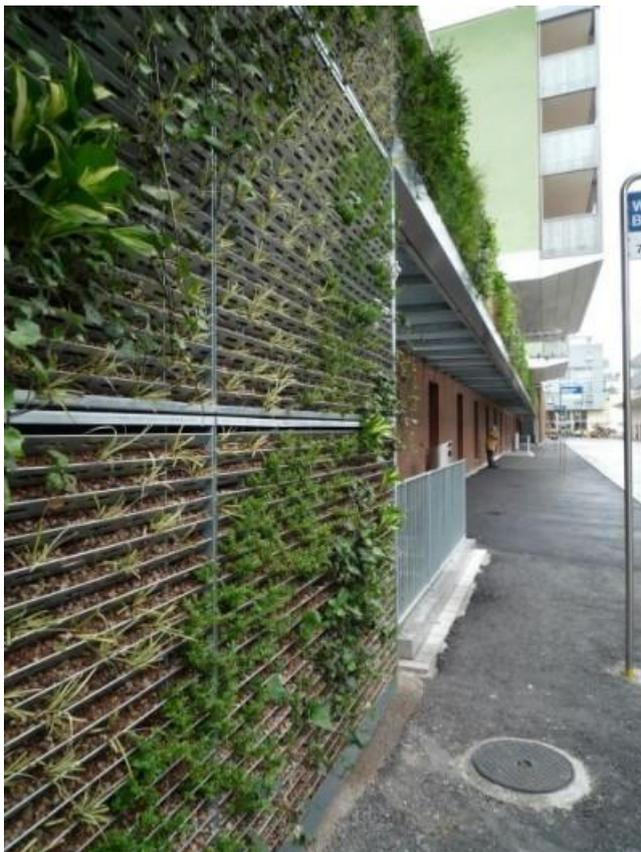
Abbildung 19 Stahlkonstruktion mit Substrat
