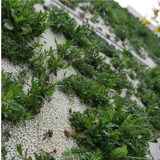
Abbildung 16 bewachsenes Fassadenmodul von SKYFLOR
