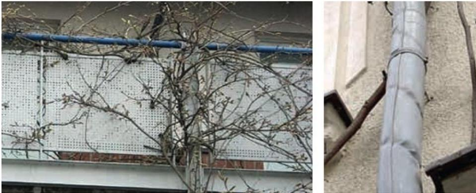
**Abbildung 13 links; Das durchlöchernde Blech wird von Glyzinien Trieben durchwachsen, die durch das Dickenwachstum abgeklummt werden und sterben, rechts; Glyzinientrieb hat sich um eine Regenrinne gewickelt und dieses deformiert.**
