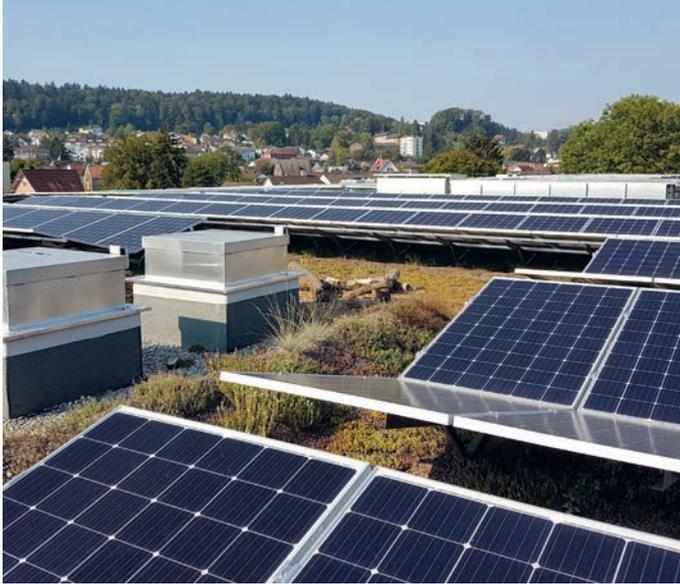
Zwischen den PV-Modulen ist Platz für Substrathügel, flache Holz- oder Steinhaufen sowie Sandlinsen für Wildbienen.
