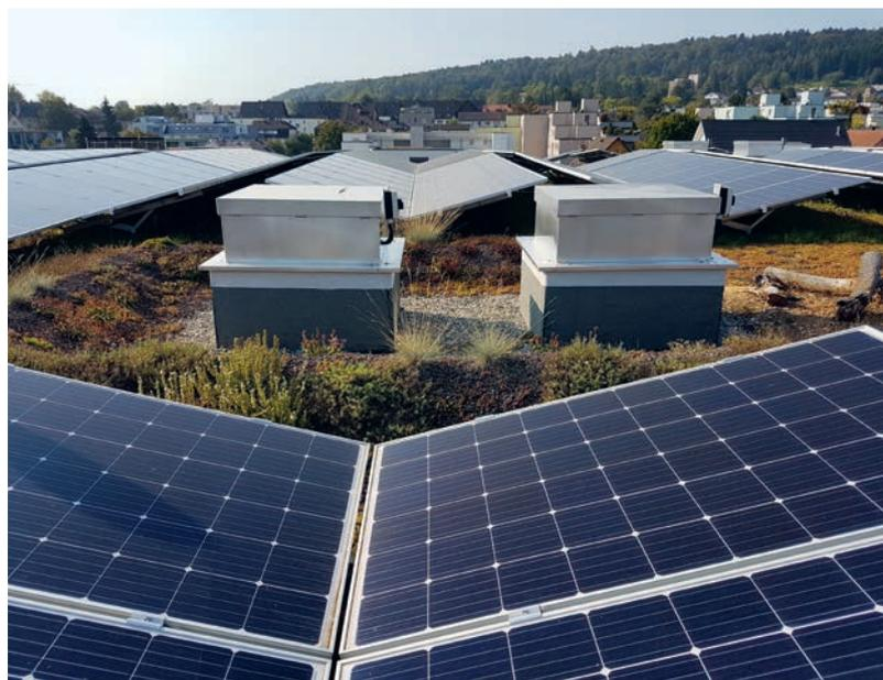
Die Anordnung der Photovoltaikmodule ist für das Funktionieren eines Kombidachs zentral. Oft werden die Module v-förmig in Zweierreihen auf dem Dach aufgeständert.
