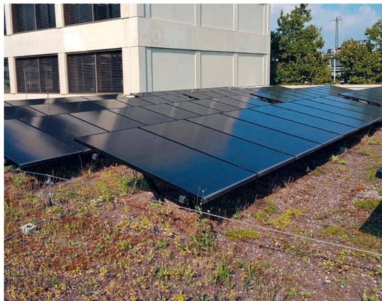
Die Module kann man auch in Einerreihen mit ausreichend Abstand für den Unterhalt montieren. Der hohe Anteil an Lava und Bims im Substrat hemmt die Vegetation auf diesem Dach.
