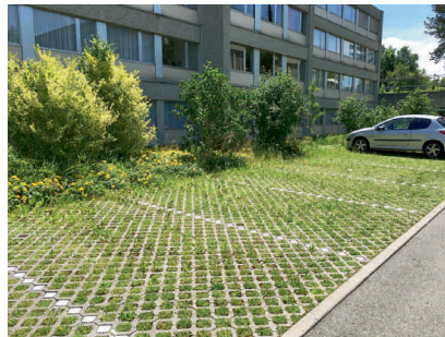
Verkehrsflächen mit versickerungsfähigen Belägen, befahrbarer Schotterterrassen
